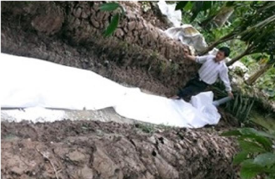
*Pose du réservoir de lisier en nylon à triple épaisseur dans un fossé creusé suivant les instructions de l'*
