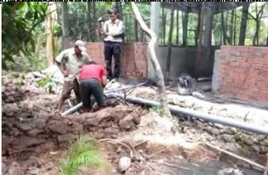
*Installation des conduites d'évacuation d'eau et du lisier de la porcherie au digesteur et vers le réservoir*
